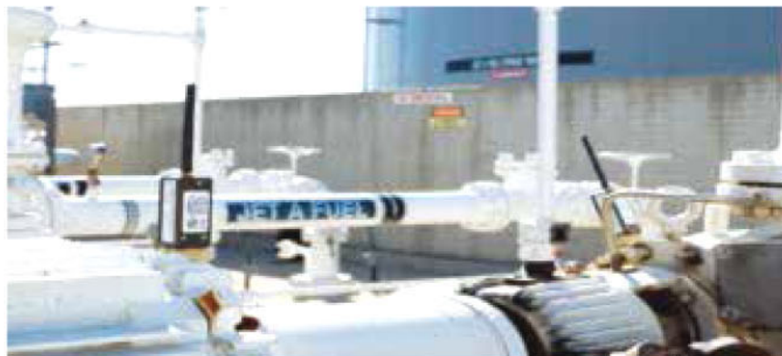
图1: 机场油库中严酷的RF环境—凌力尔特的SmartMesh IP WSN使TDG Technologies的传感器能够在危险区域和金属障碍物中可靠通信
